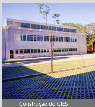
Construção do CIES
